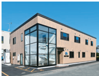
「ZEB Ready」認証を受けた中央バス商事(株)の新社屋
