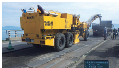
神恵内橋 補修工事
