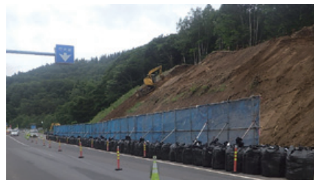
RCM（ロッククライミングマシン）での法面掘削
