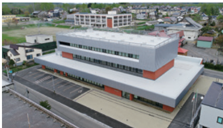
ニセコ町役場新庁舎建築工事
