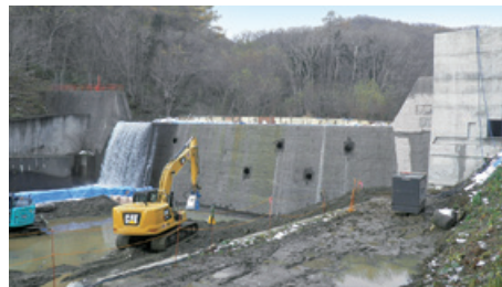
神恵内村 珊内川砂防工事
